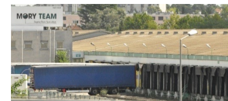
Les entrepôts et le transport
